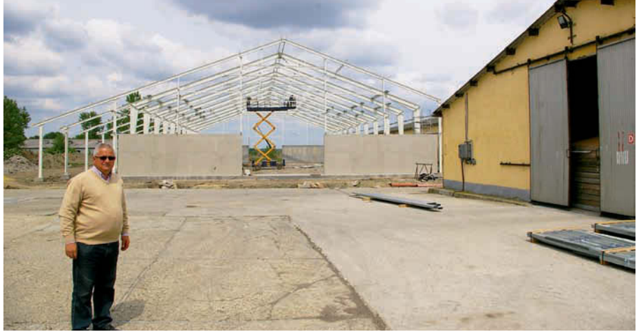
Az épülő siktároló 3 500 tonna termény befogadására lesz alkalmas júliustól
